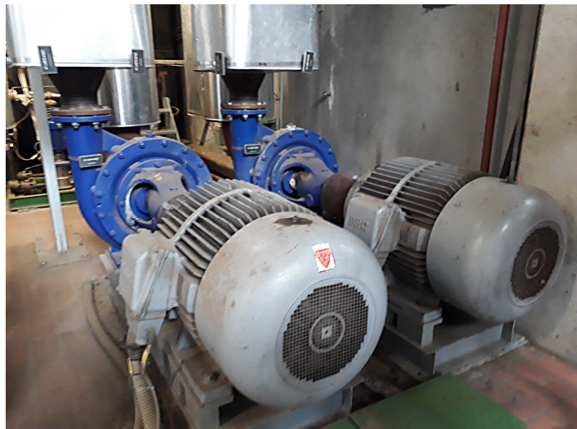
Das „Herz“ der Sulzbach-Rosenberger Fernwärmeversorgung: Diese Pumpe versorgt alle angeschlossenen Einheiten mit 90°C heißem Wasser.
