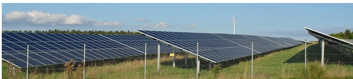
*Oben: Eine Pultdach-förmige Aufständering nach Süden mit ausreichendem Abstand zwischen den Modulflächen (PV-Anlage bei Traunfeld) lässt ausreichend direktes Sonnen- und indirektes Himmelslicht auf den Boden für artenreiche Vegetation auch unterhalb der Modulflächen.*
